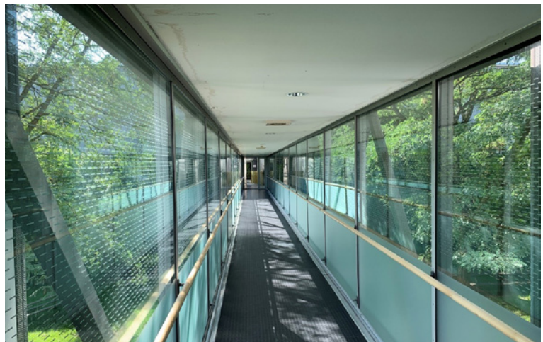
Verglaster Übergang zwischen LWF und TUM-Forstgebäude mit neuen Vogelschlag-Schutzfolien. Foto: D. Gerstmair, LWF
